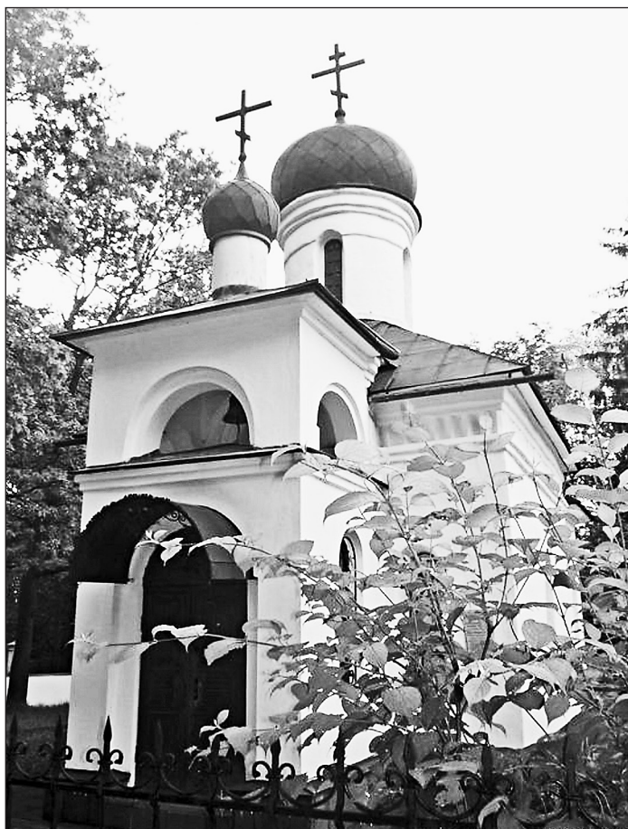
Церковь Усекновения главы Иоанна Предтечи в Семхозе
